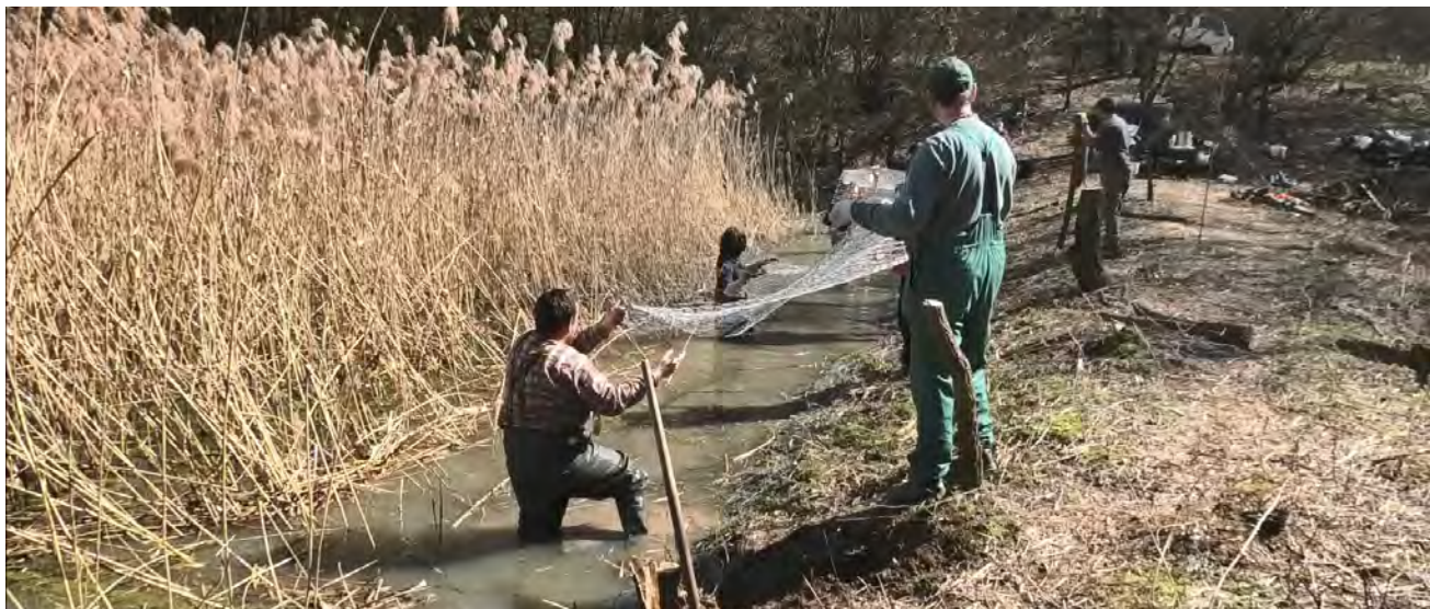
Slika 177. Polaganje mreže za zaščito brežin na Madžarskem.
