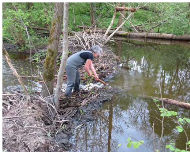
Sliki 133 in 134. V jezu ročno naredimo odprtino, odstranimo veje in blato. Pri tem si lahko pomagamo tudi z vrtnim orodjem (motika ali kramp).
