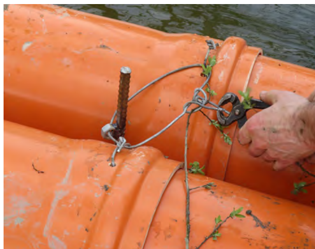
Sliki 131 in 132. Dve povezani in v dno zabiti železni palici pomagata sidrati nameščeno cev (levo), za dobro pritrditev cevi lahko na železno palico pritrdimo matico, povežemo ju z debelejšo žico.
