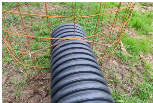
Sliki 127 in 128. Cev lahko pritrdimo s pomočjo železne palice in močnejše žice.
