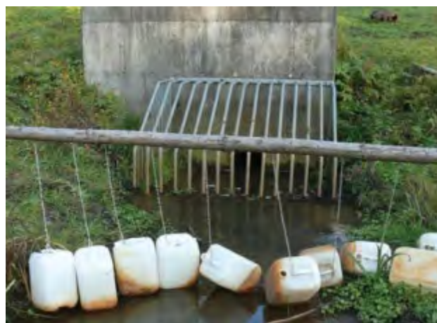
Slika 150. Viseče plastične posode bobru onemogočajo gradnjo in stabilizacijo jezov.
