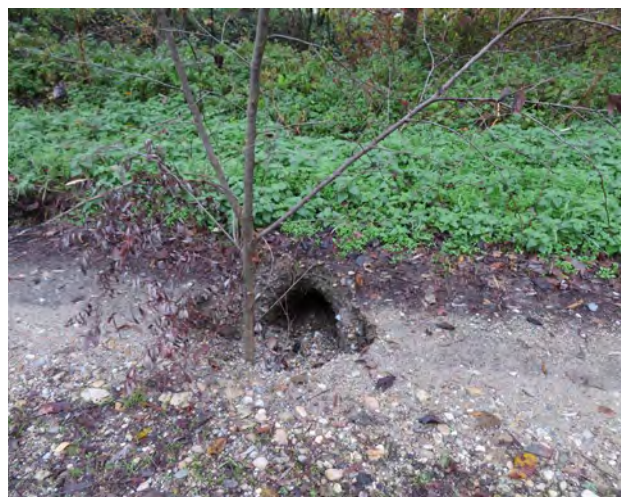
Sliki 165 in 166. Udora rova na lokalni cesti.
