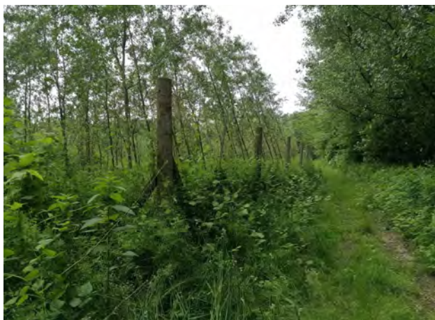
Slika 86. Izključitvena ograja z lesenimi podpornimi stebri.
