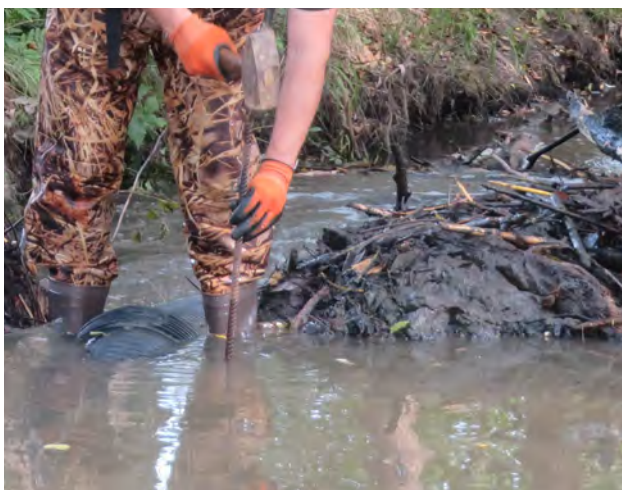
Sliki 131 in 132. Dve povezani in v dno zabiti železni palici pomagata sidrati nameščeno cev (levo), za dobro pritrditev cevi lahko na železno palico pritrdimo matico, povežemo ju z debelejšo žico.
