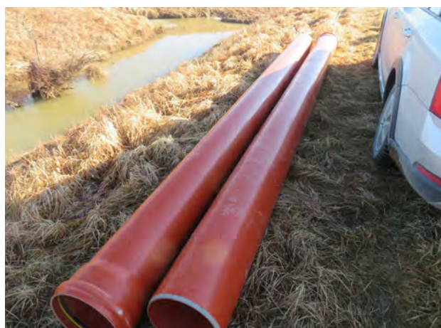
Sliki 120 in 121. Polietilenske rebraste cevi (levo) in PVC-kanalizacijske cevi (desno).
