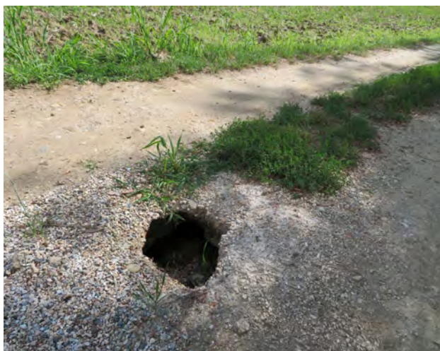
Sliki 165 in 166. Udora rova na lokalni cesti.
