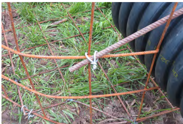
Sliki 127 in 128. Cev lahko pritrdimo s pomočjo železne palice in močnejše žice.
