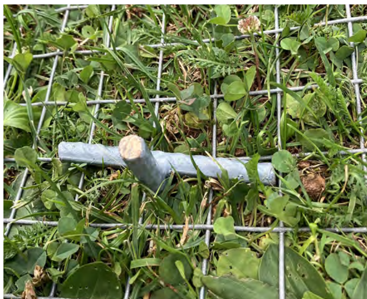
Slika 179. Pritrditev mreže z železnimi palicami.
