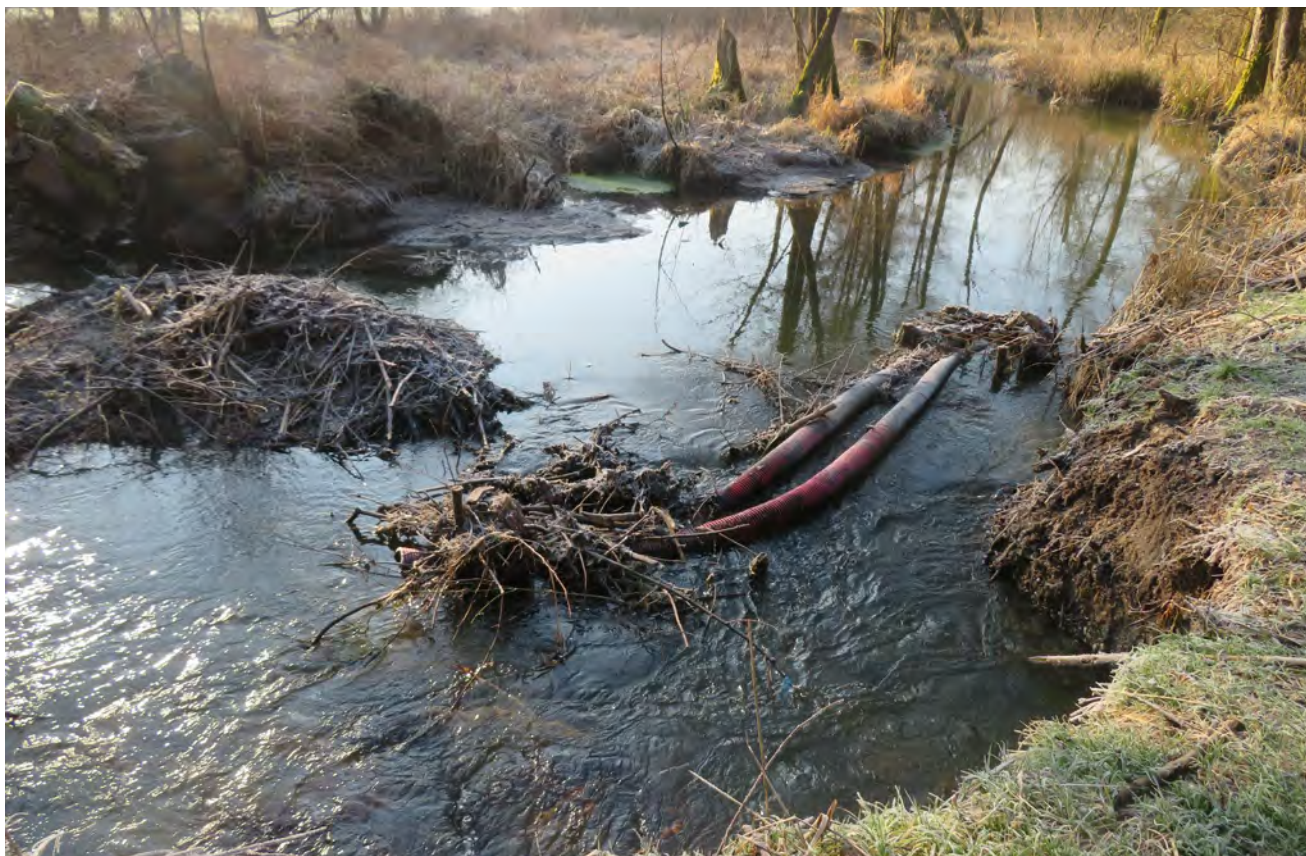
Slika 141. Ker cevi in kletka niso bili pritrjeni, je ob visoki vodi del jezusa odneslo, cevi pa prestavilo več metrov dolvodno.
