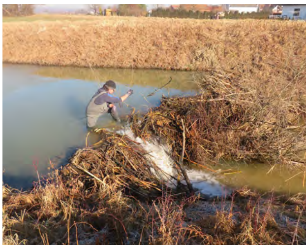
Sliki 133 in 134. V jezu ročno naredimo odprtino, odstranimo veje in blato. Pri tem si lahko pomagamo tudi z vrtnim orodjem (motika ali kramp).
