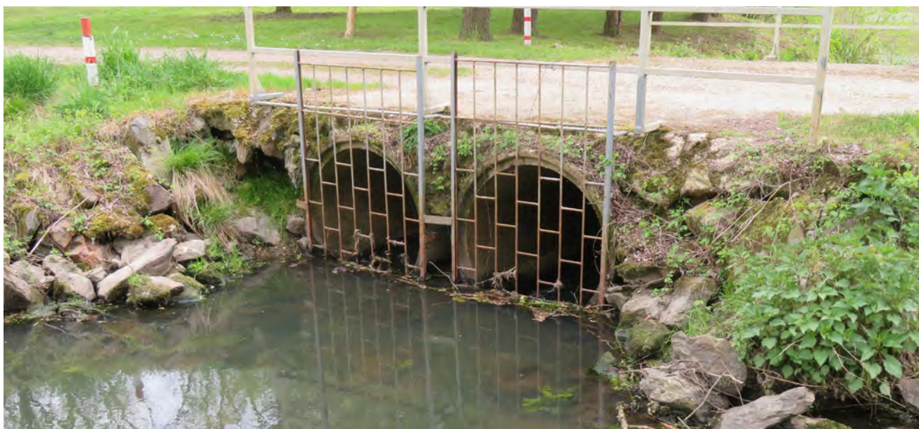
Slika 148. Z rešetkami zaščiten cevni prepust.
