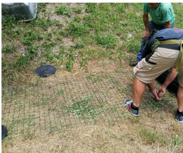
Slika 66. Najprej pripravimo ustrezno dolžino mreže, ki mora biti dovolj dolga, da bo zagotovljen ustrezen odmak od drevesa (vsaj 15 cm).
