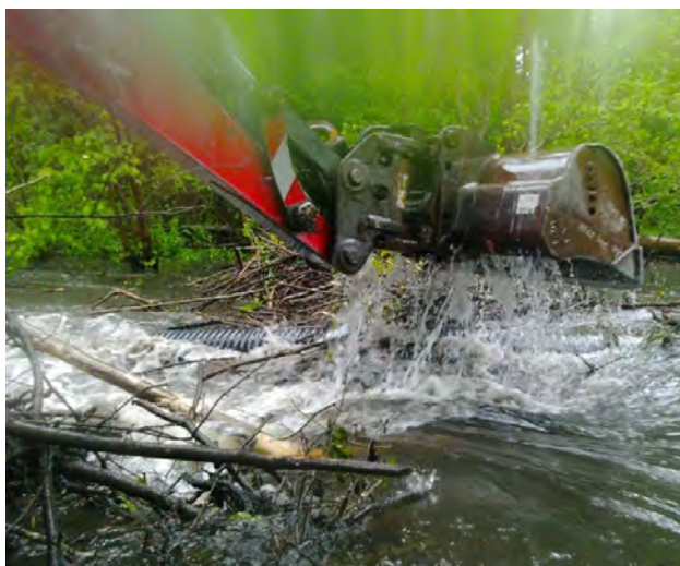
Slika 153. Jezove najhitreje odstrani bager, za dostop je pogosto treba odstranjevati obrežno vegetacijo.
