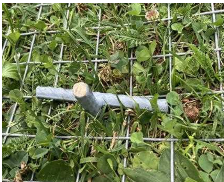
Slika 179. Pritrditev mreže z železnimi palicami.
