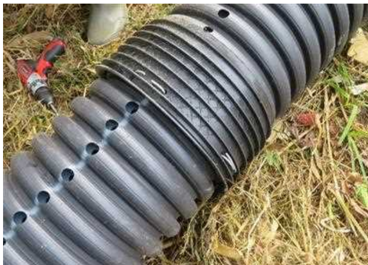
Slika 124. Navrtane luknje omogočijo izhajanje zraka in potopitev PE-cevi z dvojno steno.
