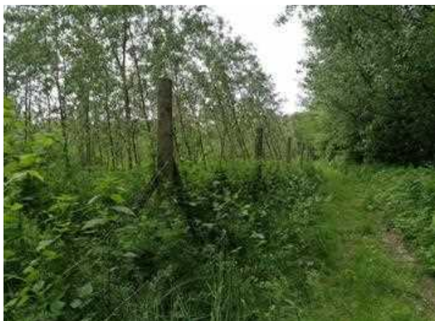
Slika 86. Izključitvena ograja z lesenimi podpornimi stebri.
