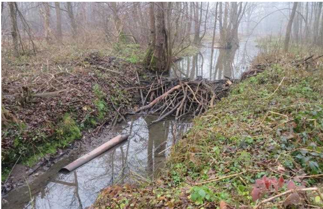
Slika 142. Odlomljen del cevi v strugi vodotoka.
