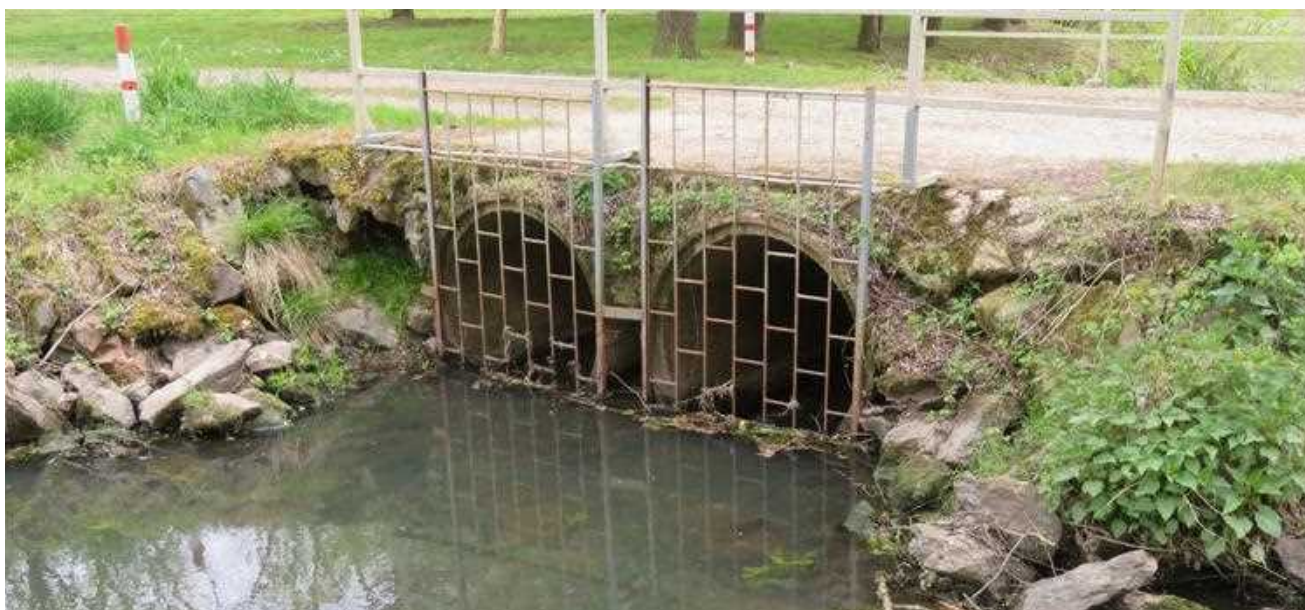
Slika 148. Z rešetkami zaščiten cevni prepust.
