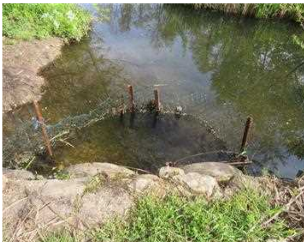
Sliki 145 in 146. Preprosta zaščita cevnege prepusta z mrežo in kovinskimi količki.
