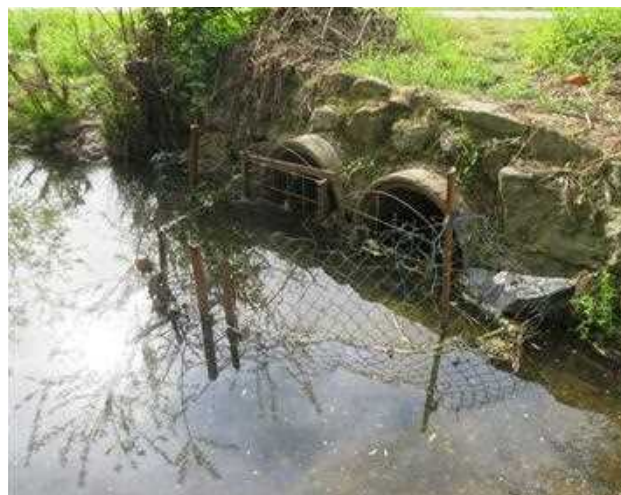
Sliki 145 in 146. Preprosta zaščita cevnege prepusta z mrežo in kovinskimi količki.
